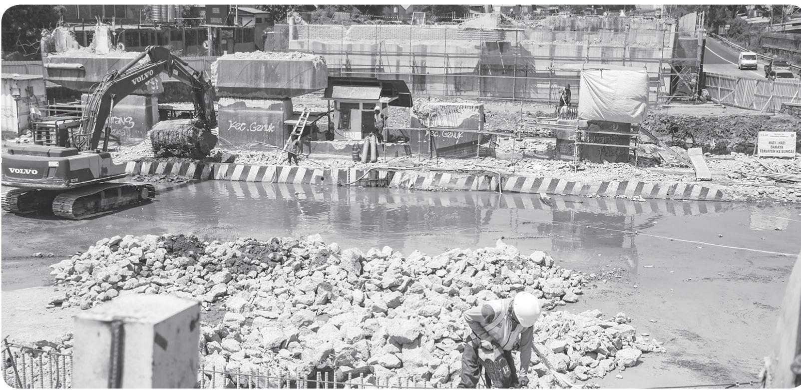
PROYEK PENINGGIAN JALAN DAN JEMBATAN TOL SEMARANG-DEMAK
